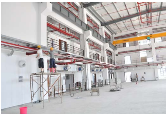
维修站及仓库
