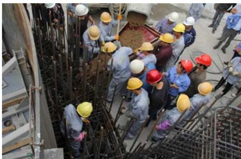
11 月 4 日，靶站密封筒底部重混凝土浇筑工作在多部门的密切配合下圆满完成。
