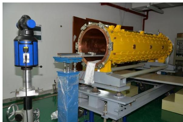
9 月 7 日下午，靶站密封筒顺利吊装就位，与之前安装的靶站基板共同组成靶站设备的基础与密封环境，成为靶站整体安装的又一阶段性成果。
