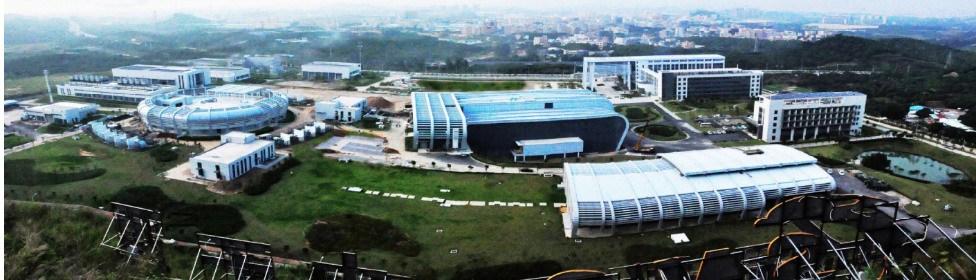
中国散裂中子源工程进展照片(2016.12)
