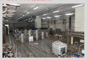
2017 年初,CSNS 靶站水冷却系统顺利完成了所有 设备的生产制造和安装任务,为下一阶段工作的继续开 展提供了宝贵的经验和坚实的基础。
